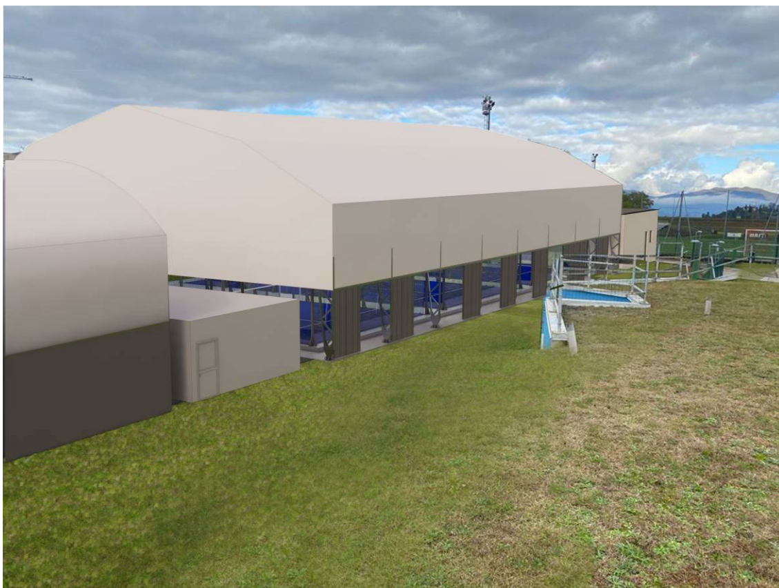
VISTA INTERNA ALL'AREA DA SUD/EST
